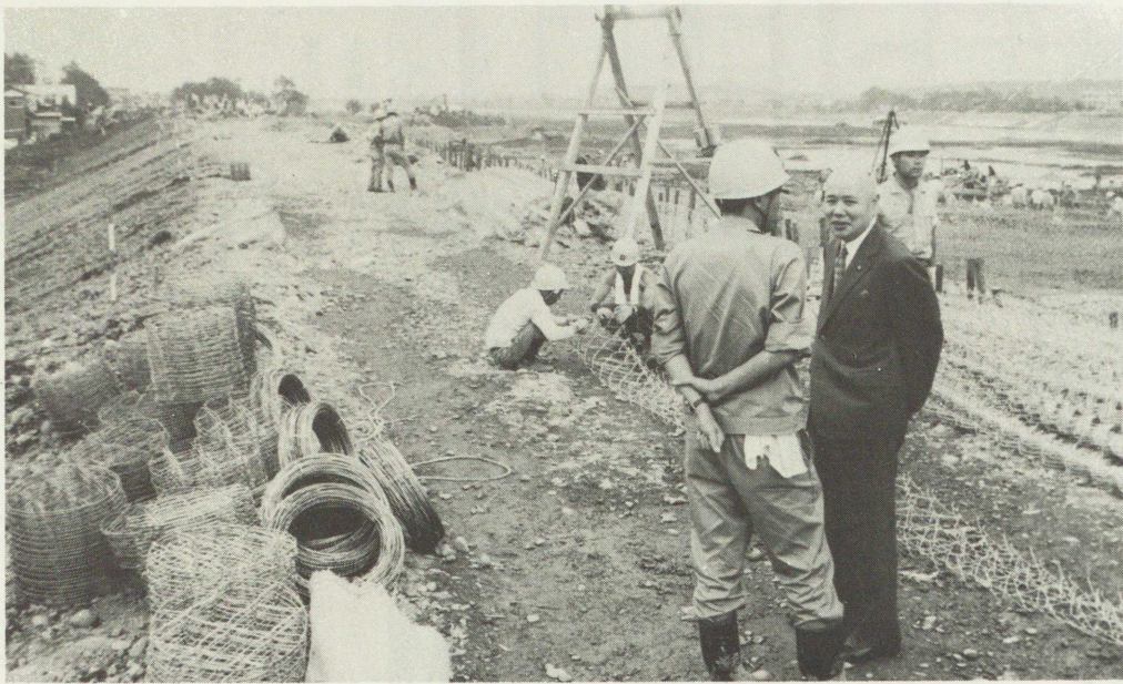
完成した仮堤防を見る市長
